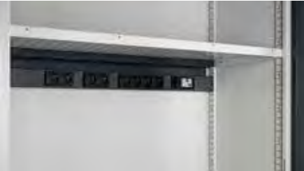
Applicazione canaletta elettrica sulla parte inferiore del piano-pannello forato
